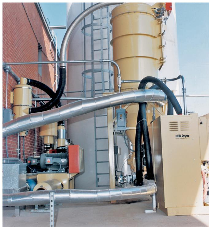
过滤接收装置将轨道车内的尿素输送至储粮仓以及带消音器和后置冷却器的鼓风机组件。
